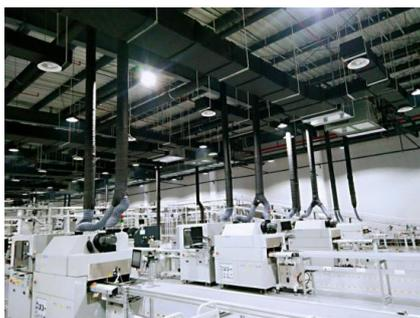
焊接废气处理装置
