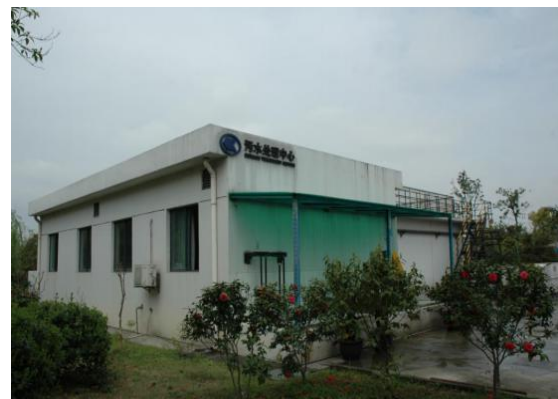
建立污水处理中心，实施污水处理
