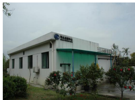
建立污水处理中心，实施污水处理
