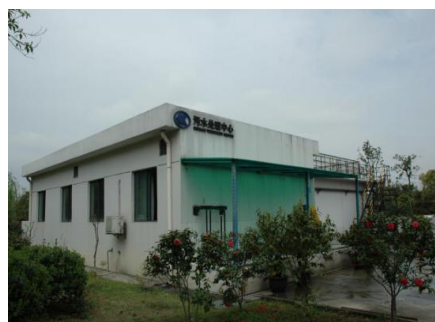
建立污水处理中心，实施污水处理
